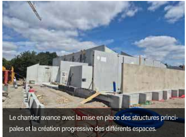
Les murs de la future salle polyvalente sortent de terre, laissant déjà deviner les volumes du nouvel équipement communal.
