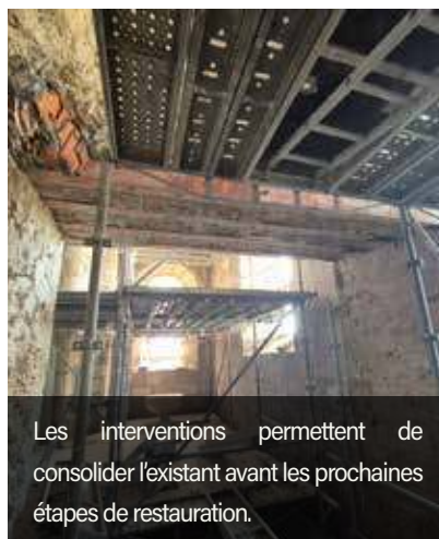
À l'intérieur de l'église, les travaux avancent dans le respect de l'édifice et de son histoire.
